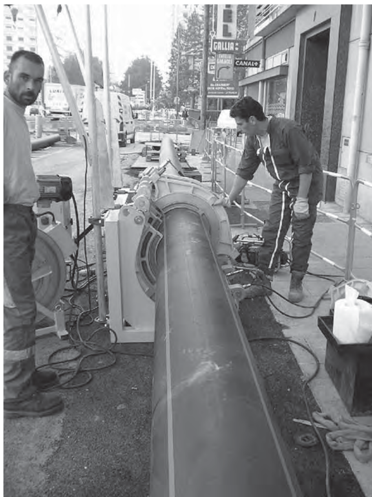
Plate 13. Welding a plastic sewer pipe in 2004 in Grenoble, France (Photo: Régie des Eaux de Grenoble)
