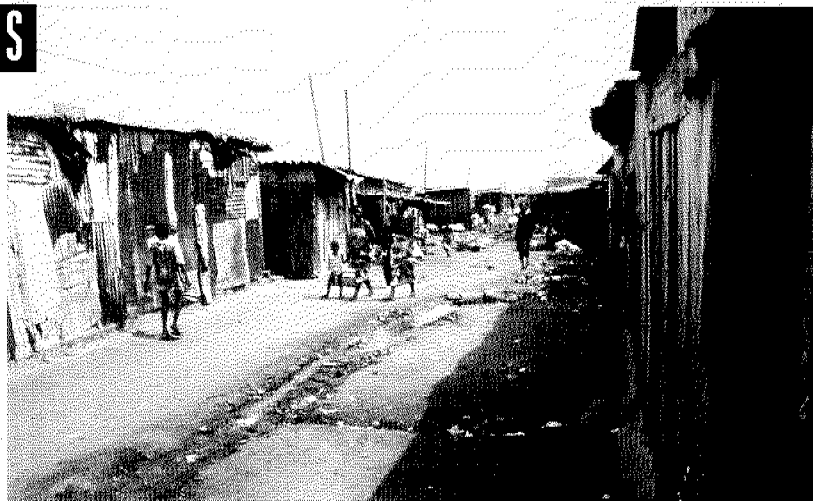
Bidonville résiduel dans une zone inondable non encore viabilisée. Baraques en matériaux de récupération très morcelés. Lignes électriques pirates. Sur l'unique rue en terre, improbables rigoles d'eaux usées.
