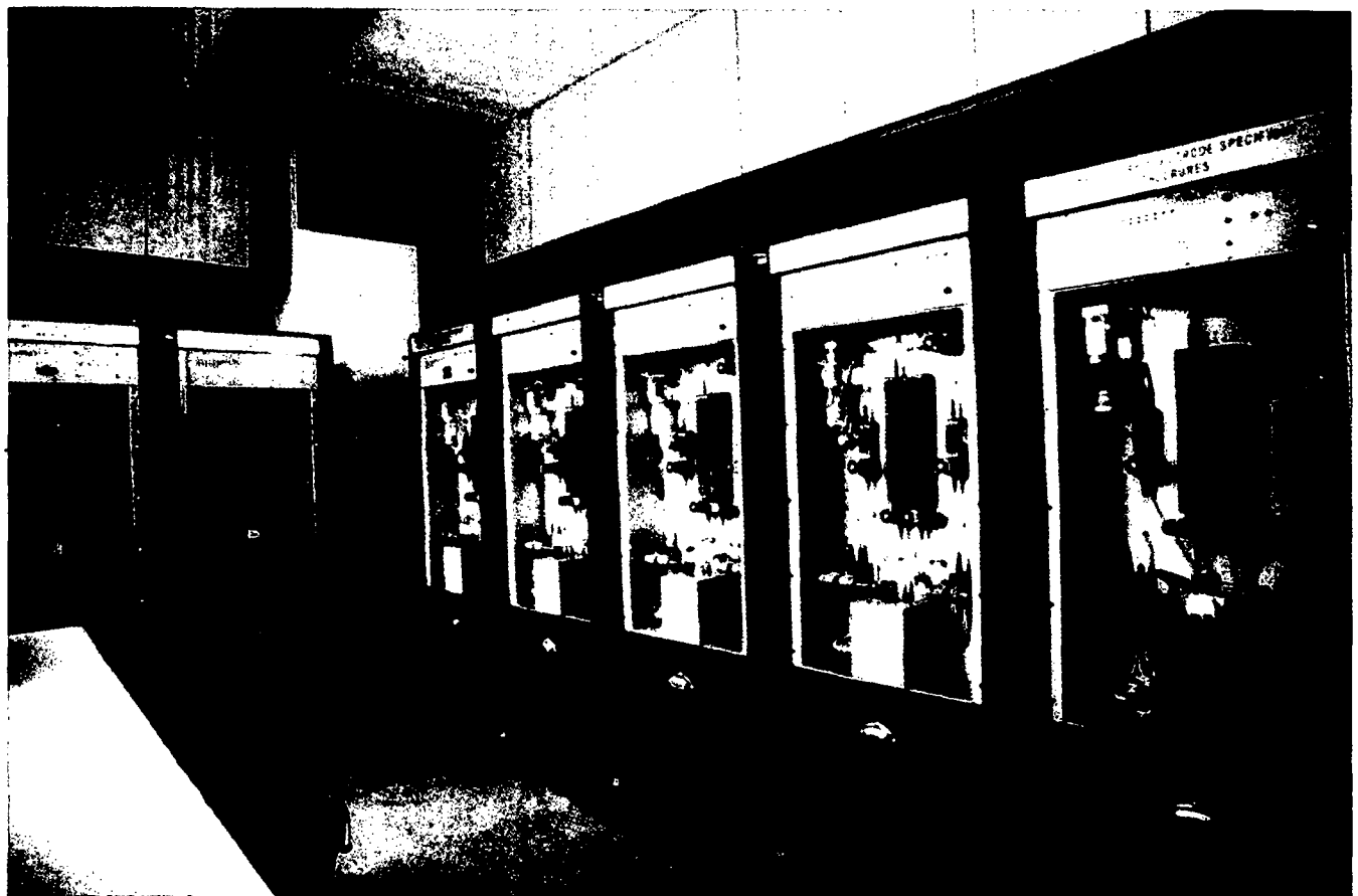
Station de détection automatique de la pollution
