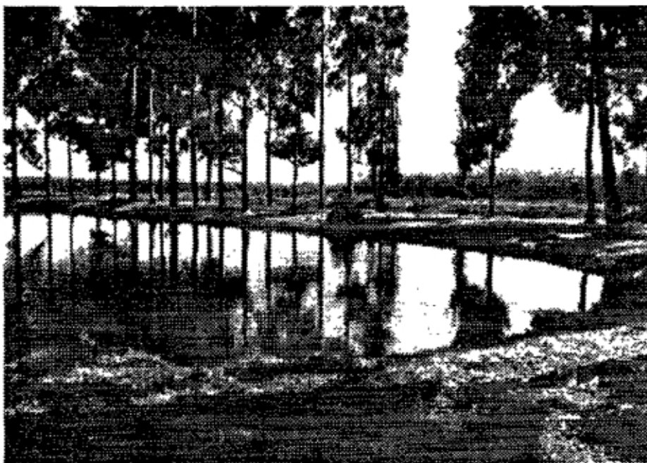
Deuxième étang de stabilisation avec le troisième en arrière plan
