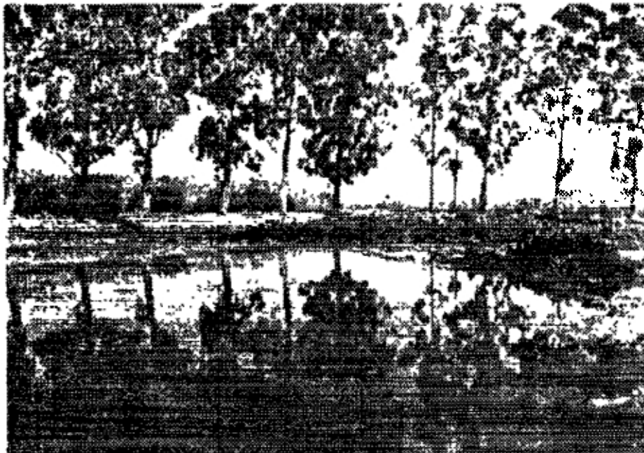
Premier étang de stabilisation avec dépôts à l'entrée
