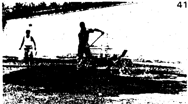
Aufbringen des Splittes mittels hydraulischer Transportanlage in das Becken 3.
