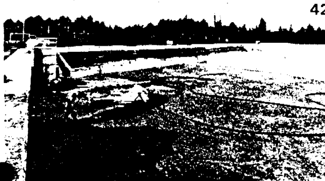
Aufbringen des Splittes in das Becken 3. Links neuer Messschacht.
