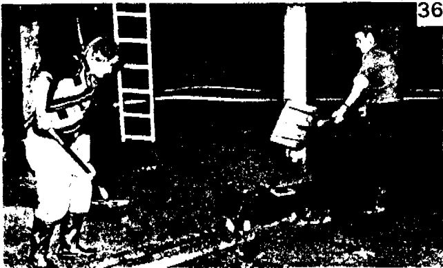
Der Sand wird in den Injektortrichter geschaufelt.
