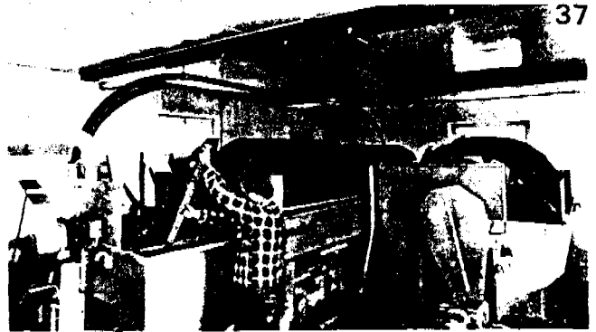
Sandwaschmaschine im Werk Moos für Reinigung des Sandes und des Kieses mit Sortieranlage.
