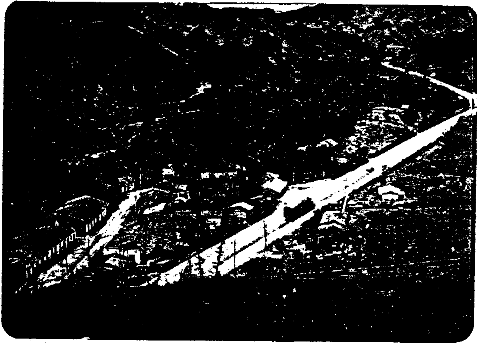
VISTA GENERAL. CORREGIMIENTO QUEBRADA NUEVA, MUNICIPIO DE ZARZAL
