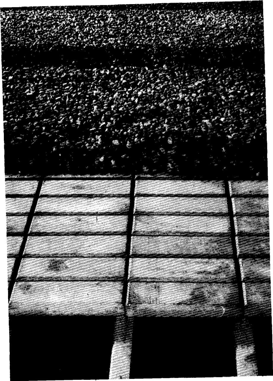
Réseau de drains et couches de gravier de support, Service des Eaux d'Amsterdam (Pays-Bas).
