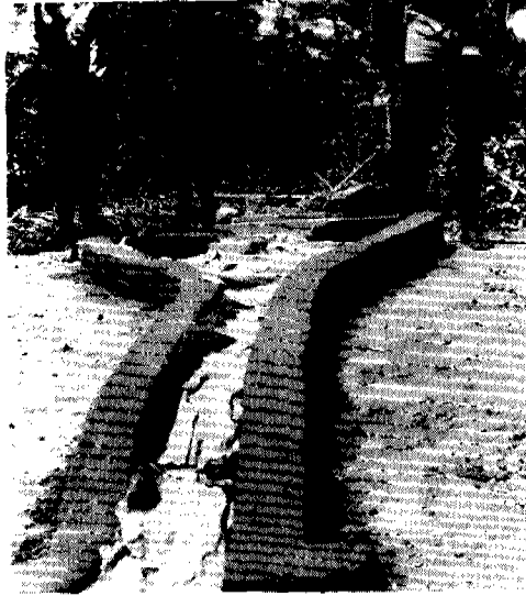
Figure 6.6 Il est plus efficace d'utiliser du sable ou des feuilles humides pour faire durcir le béton que ces sacs non mouillés. Il est essentiel de garder le béton humide pendant quelques jours pour qu'il durcisse convenablement.
