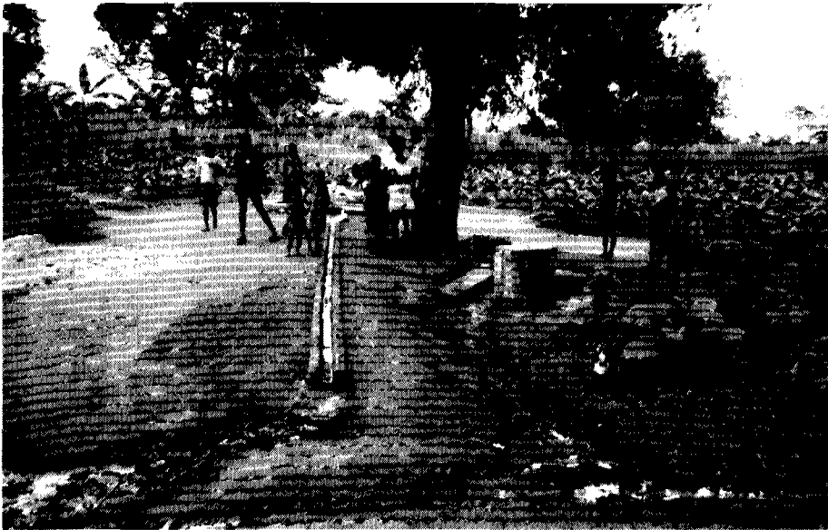
Figure 6.5 Un écoulement adéquat est essentiel et il est nécessaire de prévoir une fosse d'infiltration pour éviter les problèmes d'ordre sanitaire.
