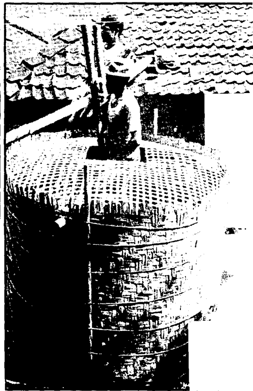
Atas : Memasang pipa peluapan. Kanan : Melubangi tutup tanki untuk lubang pemasukan air.
