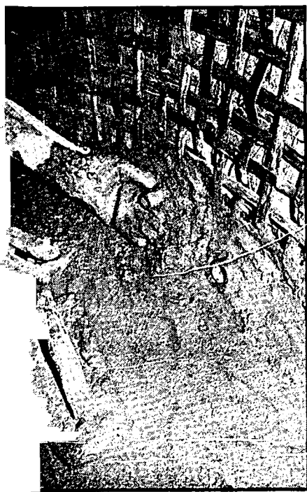
Kiri : Plaster dasar tanki bagian dalam. Bagian sudutnya dipertebal. Kanan : Plaster tahap pertama menggunakan sarung tangan karet.
