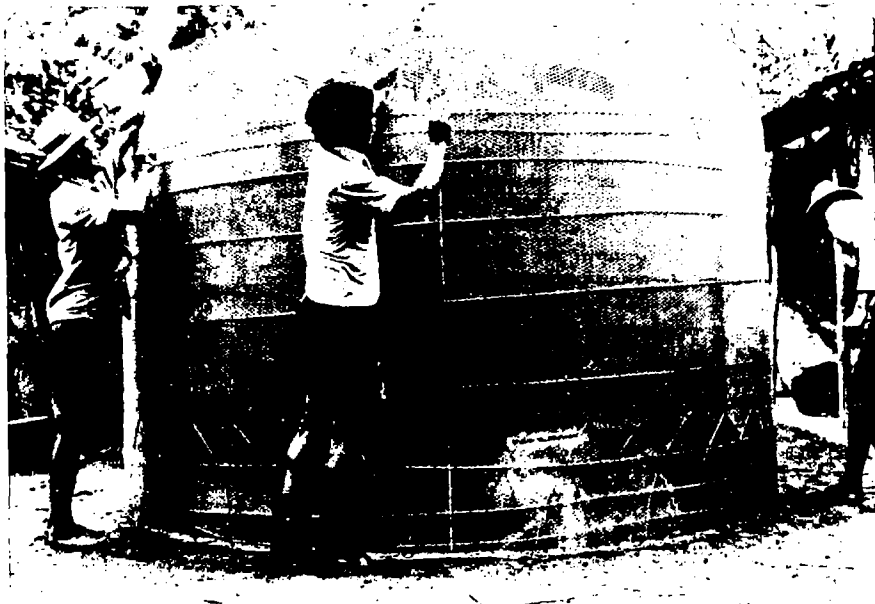
Gambar 30. Pemasangan lapis kedua kawat ayam, terlihat kelebihannya yang 30 cm.
