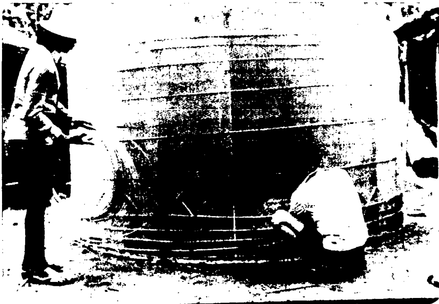
Gambar 31. Pemasangan kawat seng lapis kedua.
