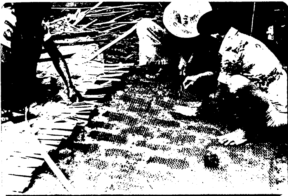
Gambar 23. Cara memotong kawat ayam.
