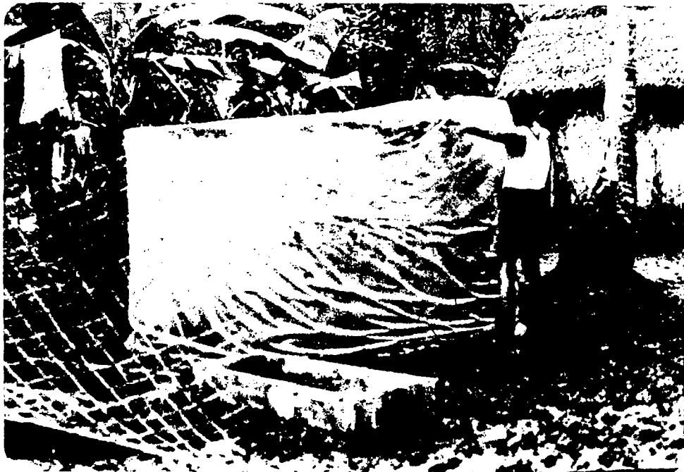
Gambar 46. Cara curing dengan lembaran plastik.
