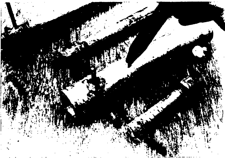
Gambar 43. Sebelum dipasang pipa dibuat kasar.
