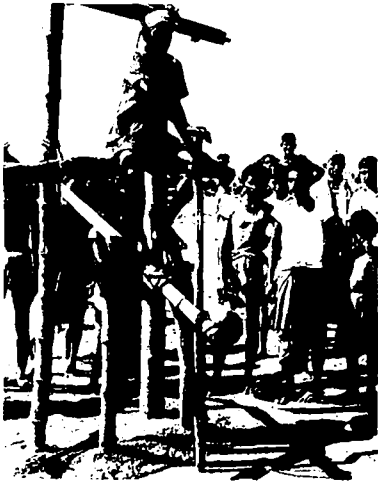
Figura 5.7 ANDAMIO, PIVOTE Y PALANCA DE BAMBU USADOS EN LA PERFORACION POR EL METODO DE CUBETA SACALODOS. (De "Jetting Small Tubewells by Hand" Water Supply and Sanitation in developing Countries . AIB-UNC/ITSED, Artículo número 15, junio de 1967).
