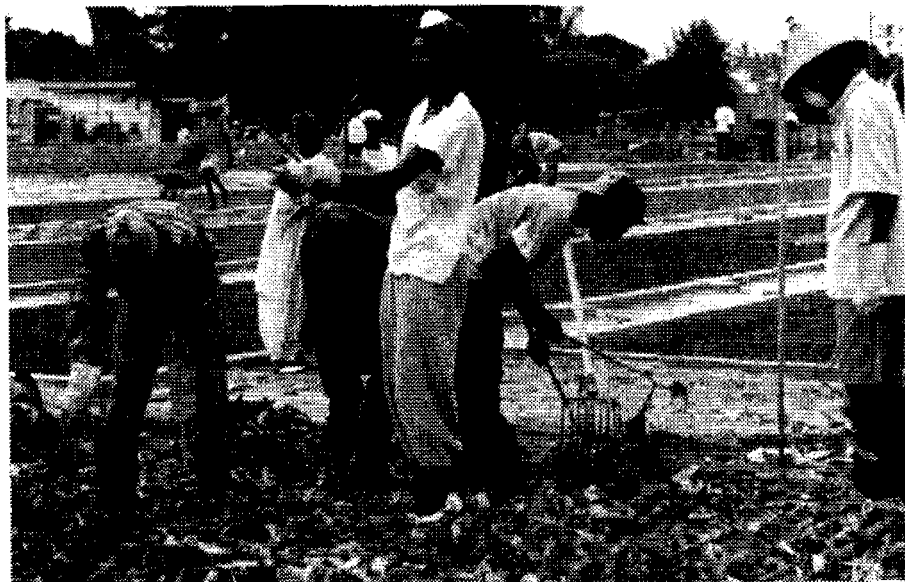
“Le travail du compostage et au second plan, la station d'épuration”
