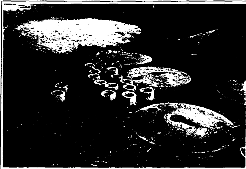
5.8 Fabrication des éléments d'une latrine (Plaque de ventilation)
