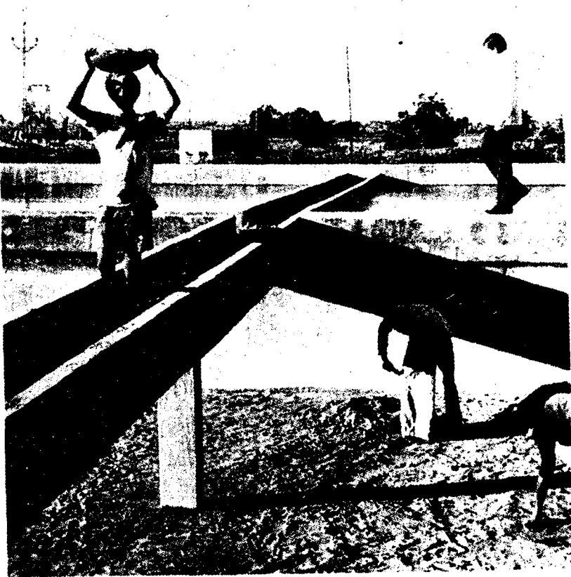
Figura 15.12 Limpieza manual de un filtro lento de arena
