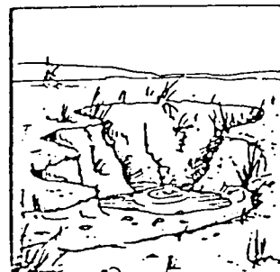
Fozo de agua con paredes derrumbadas
