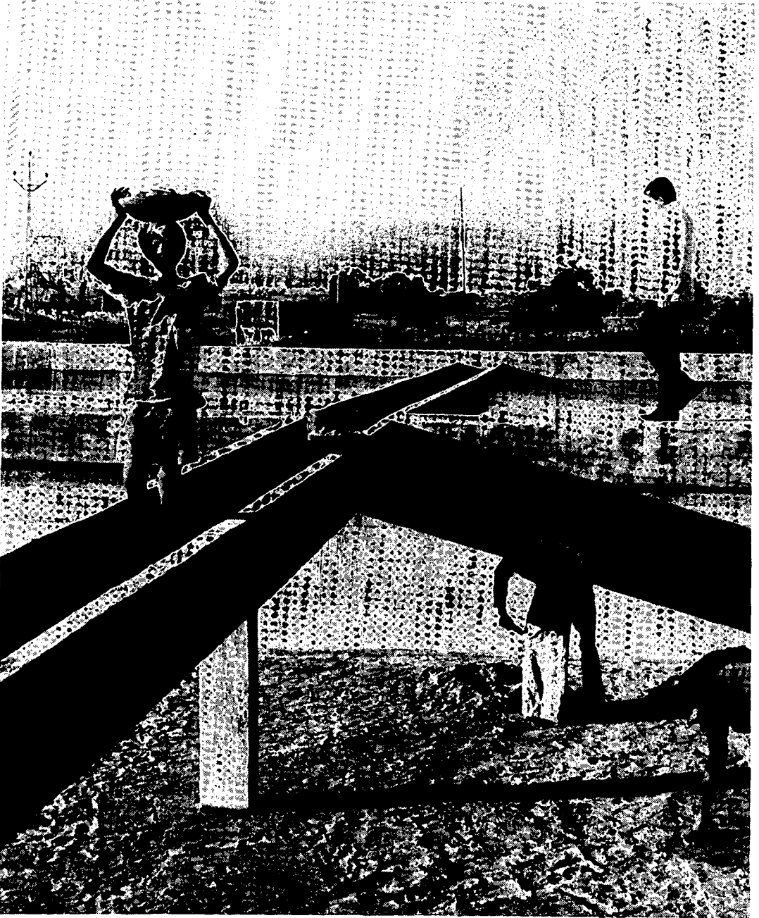
Figure 15.12. Nettoyage manuel d'un filtre lent sur sable
