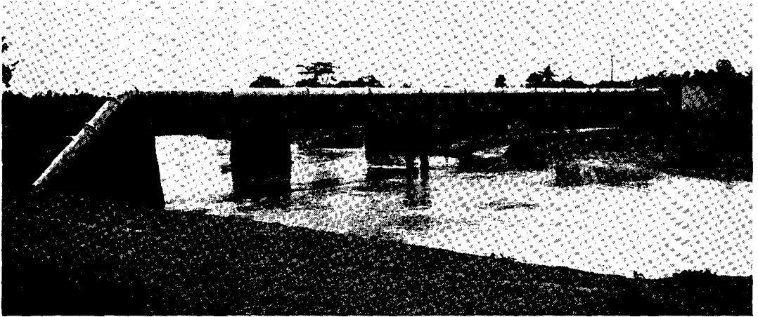
Figure 18.8 Traversée d'une rivière par une canalisation d'adduction
